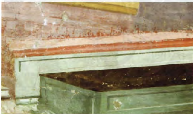
35 – PRESBITERIO – PARETE SINISTRA, GLI APOSTOLI SALUTANO MARIA, FILO BATTUTO A COLORE PER DISEGNARE SULL'INTONACO L'ARCHITETTURA DIPINTA
