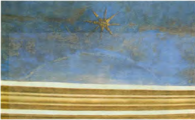
5 – VOLTA – IN CORRISPONDENZA DELLA SCENA DELLA NASCITA DELLA VERGINE, GIUNTO DI INTONACO DALLA FORMA SEMICIRCOLARE
