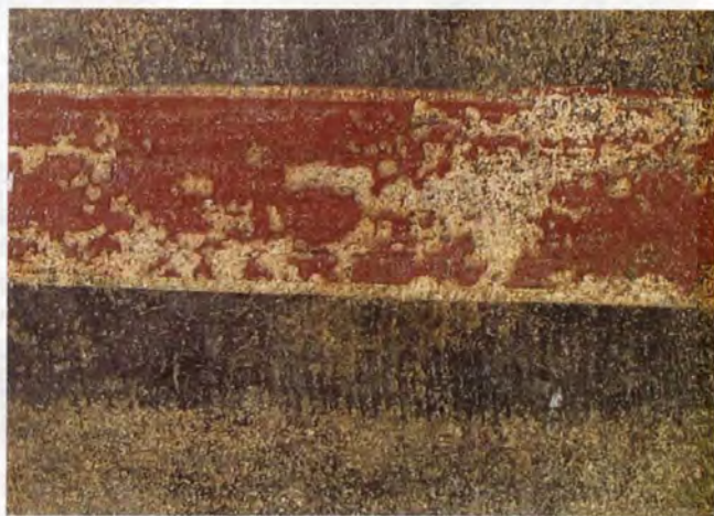
6 – POMPEI, CASA DEI VETTII, AMBIENTE "H", PARETE EST – PARTICOLARE A LUCE RADENTE CHE EVIDENZIA I SEGNI LASCIATI DALLA PRESSIONE DELLO STRUMENTO UTILIZZATO PER LA LISCIATURA DELL'INTONACO ED IL MIGLIORE STATO DI CONSERVAZIONE DEL PIGMENTO SU QUESTA ZONA RISPETTO A QUELLA LIMITROFA Pompeii, House of the Vettii, area "h", east wall – detail under raking light showing the marks left by pressing down on the tool used to smooth the plaster, and the better state of preservation of the pigment in this area compared to its surroundings
