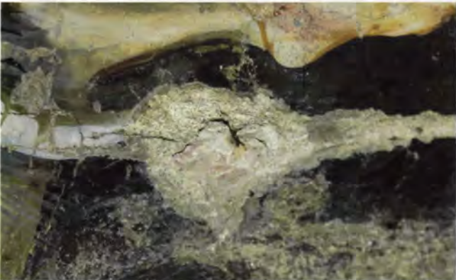
6 – CONTROFACCIATA – PICCOLA LACUNA, IN CORRISPONDENZA DELL'INFERNO, ATTRAVERSO LA QUALE È POSSIBILE VEDERE UNA TRACCIA DI SINOPIA
